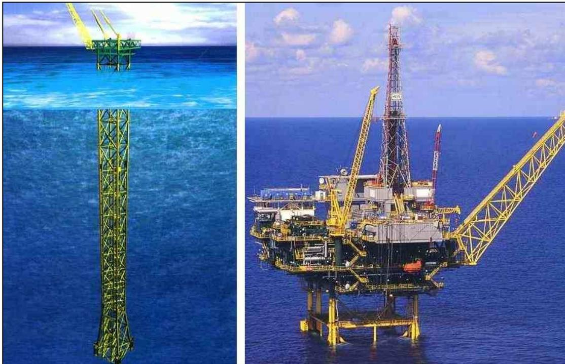
Figura 5 – Plataformas do tipo de torre complacente (CPT)
